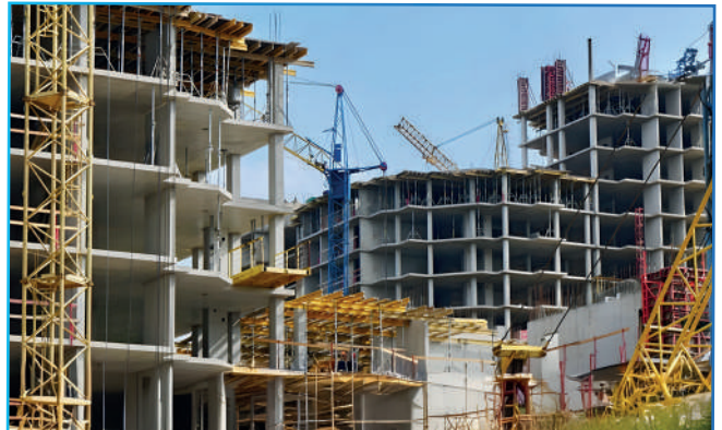
أعمال البناء والتشييد
