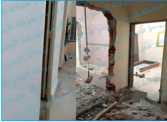
ترميم المباني وتجديد المظهر العام للمباني
