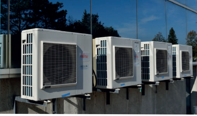
أعمال التكييف والتهوية
