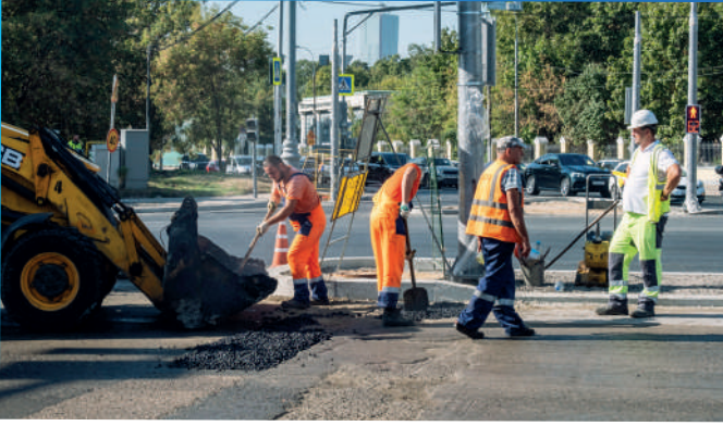
أعمال الطرق والمرافق العامة.
